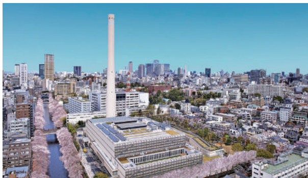
廃棄物発電プラント
