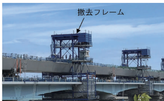
現地施工状況
