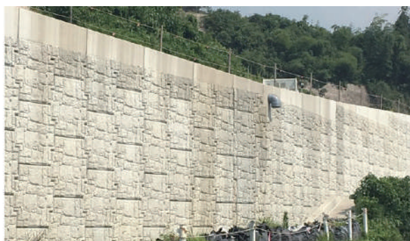
テールアルメ工法の外観
