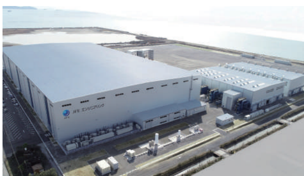
笠岡モノパイル製作所 全景
