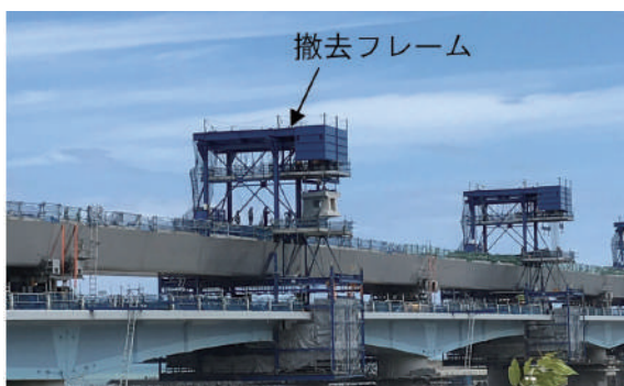
現地施工状況
