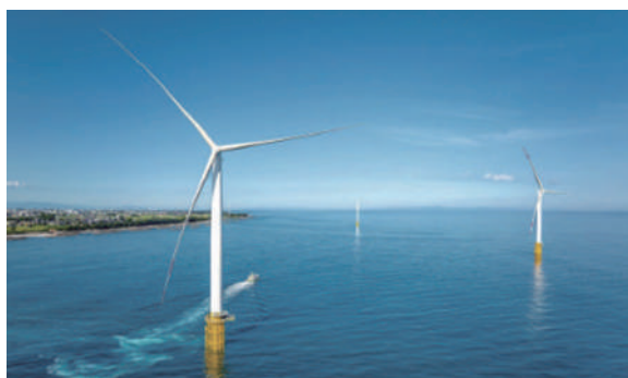
入善洋上風力発電所 (写真提供：(株)ウェンティ・ジャパン)
