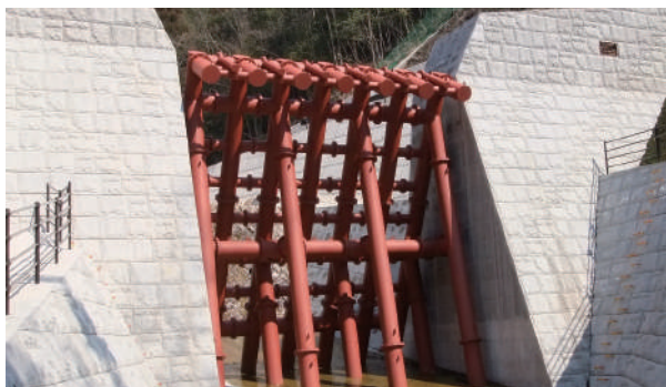
鋼製透過型砂防堰堤
