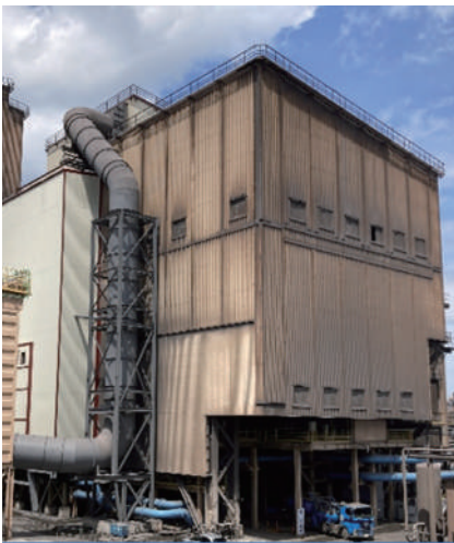
千葉地区第4製鋼電気炉の外観
