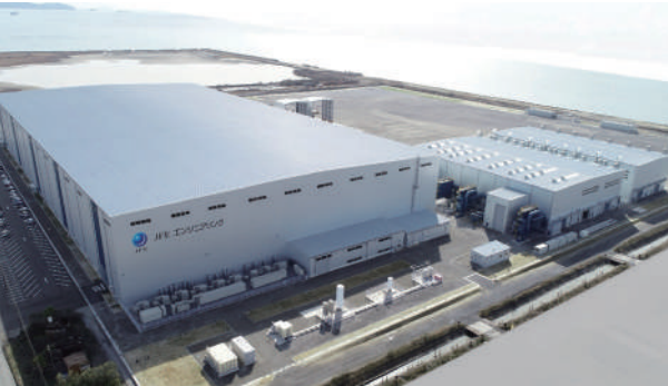
笠岡モノパイル製作所 全景
