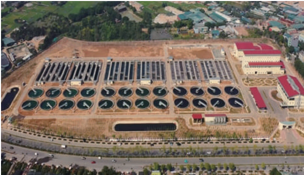
エンサ下水処理場全景
