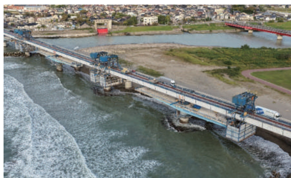
現地施工状況(撤去フレームを使用した空中での既設桁撤去)
