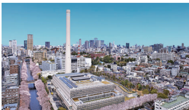
廃棄物発電プラント
