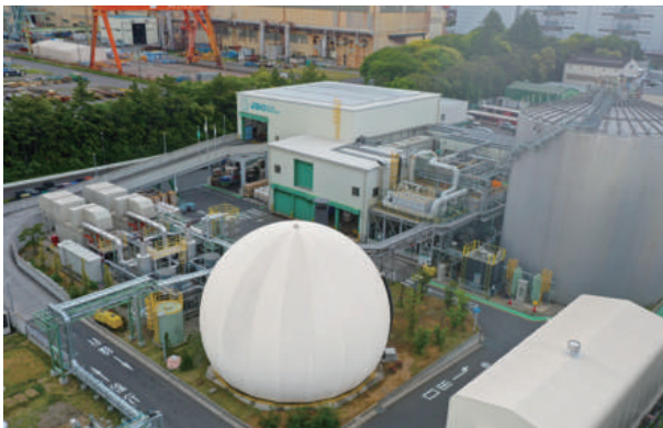
食品リサイクル発電プラント施設 (Jバイオフードリサイクル)
