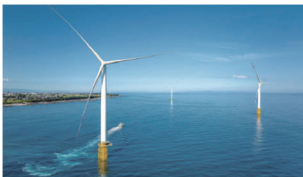
入善洋上風力発電所（写真提供：（株）ウェンティ・ジャパン）
