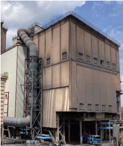
千葉地区第4製鋼電気炉の外観
