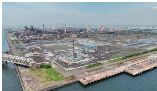
水素基地建設の状況(2026年6月撮影)
