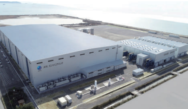
笠岡モノパイル製作所 全景
