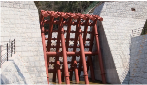
鋼製透過型砂防堰堤
