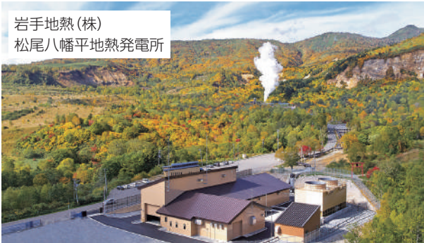
地熱発電プラント
