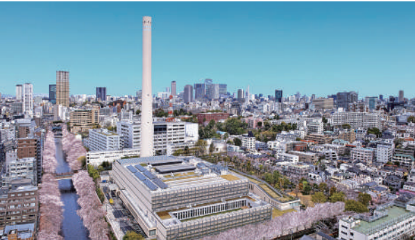
廃棄物発電プラント
