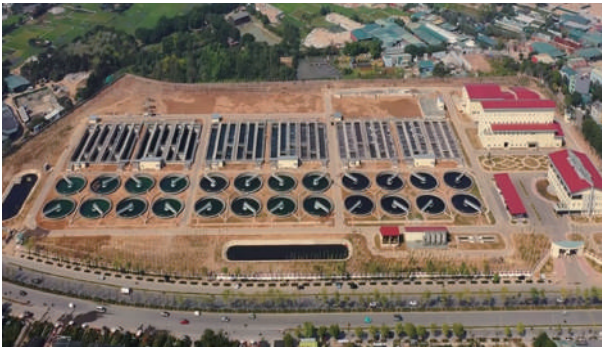
エンサ下水処理場全景
