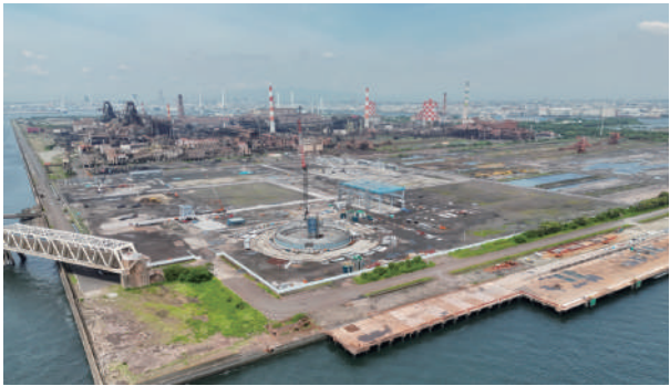
水素基地建設の状況 (2026年6月撮影)
