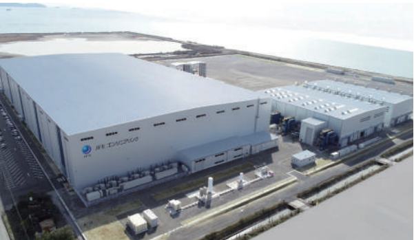
笠岡モノパイル製作所 全景
