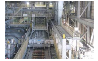
倉敷 第7連続製造設備
