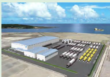
津製作所では、ジャケット式基礎や、MPと風車タワーをつなぐ部材であるトランジションピースを製作し供給する予定です。
