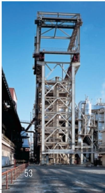
CDQは、コークス炉で乾留された赤熱コークスを、冷却塔内を流れる不活性ガスで消火する設備です。粉塵の飛散がなく顕熱回収発電が可能で省エネルギーに貢献するものです。現在、倉敷地区への拡大を進めています。
