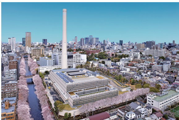
廃棄物発電プラント
