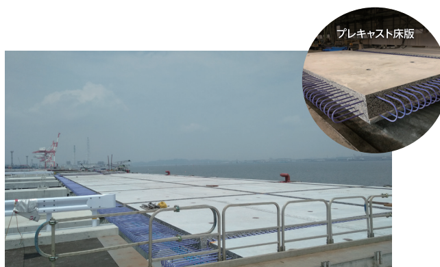
高炉スラグ細骨材を用いた栈橋のプレキャスト床版
