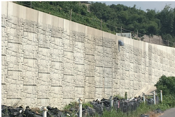
国道3号線(熊本県)での施工実績
