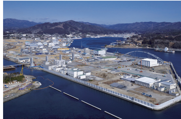
ハイブリッド防潮堤
