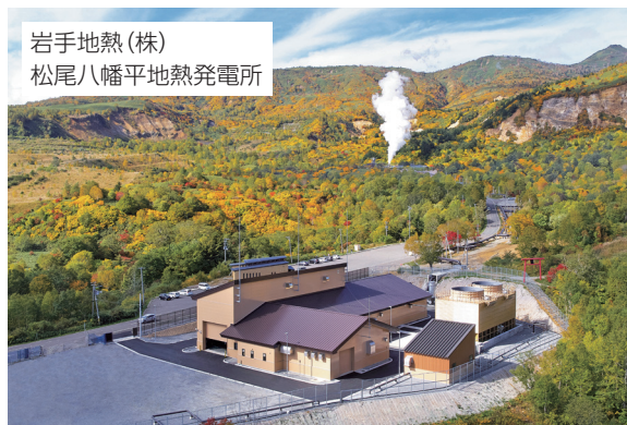
地熱発電プラント
