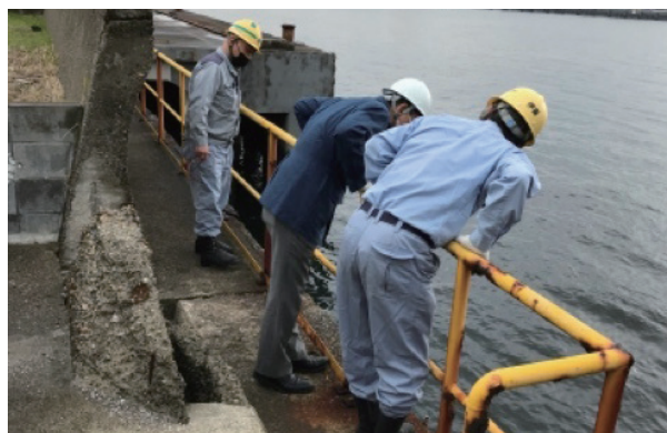
国内グループ会社の現場監査状況
