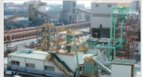
使用済みプラスチック微粉化プラント
