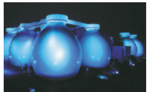
下水汚泥消化タンク
