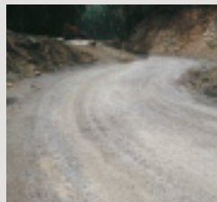
ロードタフの施工状況
