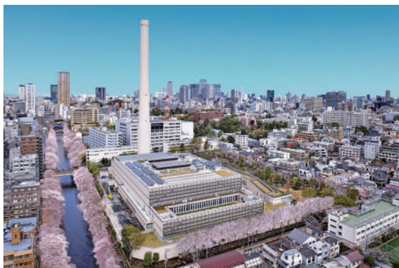
廃棄物発電プラント
