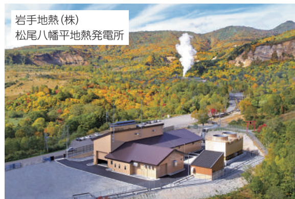
地熱発電プラント
