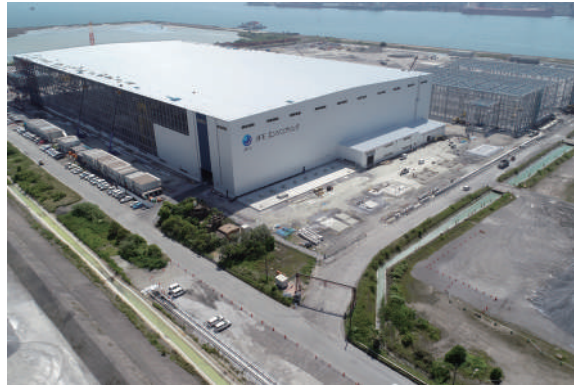
モノパイル工場建設工事の様子(2023年5月現在)
