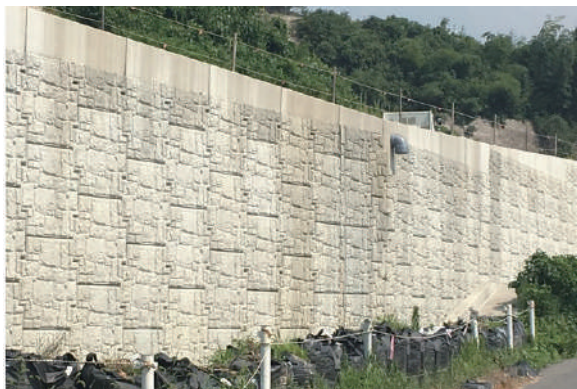
国道3号線(熊本県)での施工実績
