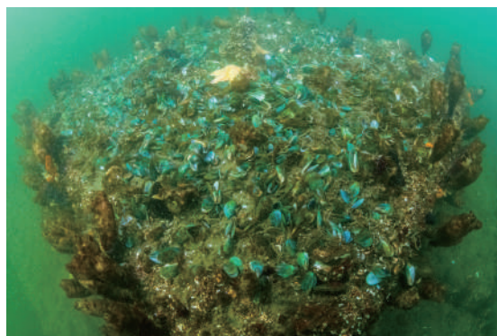
二枚貝がびっしり着生したマリンブロック® (山下公園前海域)
