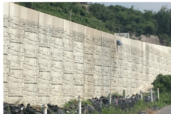
国道3号線(熊本県)での施工実績
