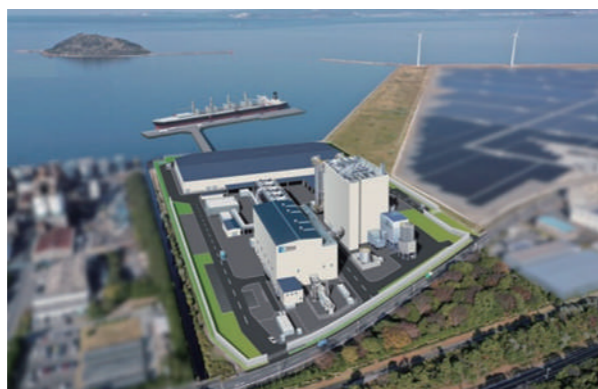
国内最大級木質バイオマス専焼発電所(田原バイオマス発電所)の完成イメージ
