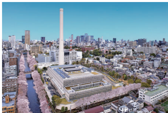
廃棄物発電プラント
