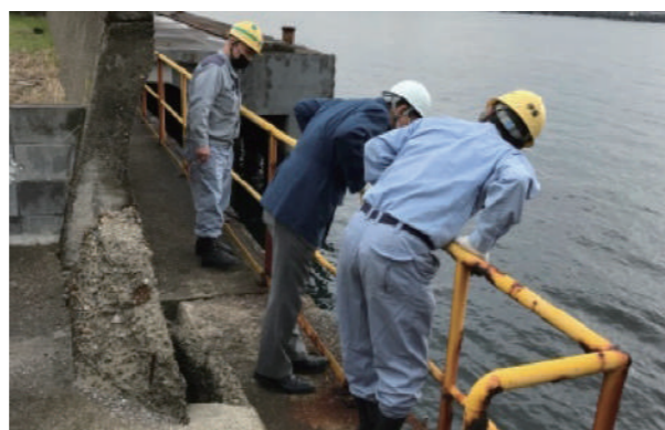
国内グループ会社の現場監査状況
