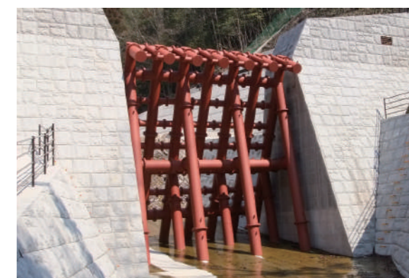
鋼製透過型砂防堰堤
