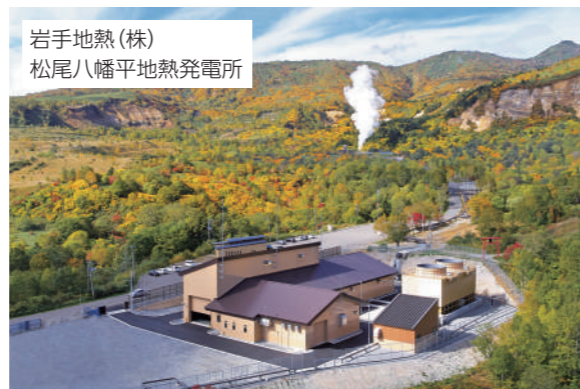
地熱発電プラント
