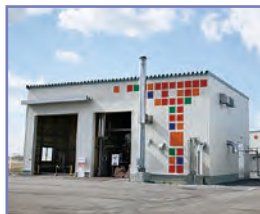
バイオマスボイラ棟
